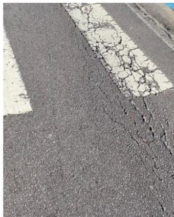
**Figura 9:** Fissuras e gretamentos ao longo do percurso estudado. Fonte: Compilação do autor
