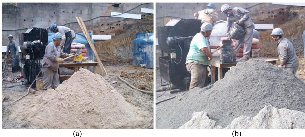
Figura 2. Agregado miúdo utilizado (a) areia natural, (b) areia artificial granítica.
