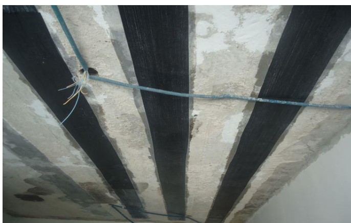
Figura 4. Foto do reforço com PRFC, em laje de concreto Fonte: (Asope, 2019).
