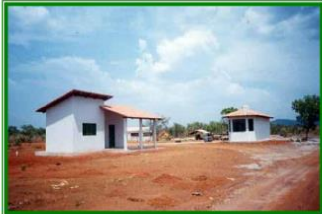
Figura 02 - Guarita, escritório e casa de balança do Aterro Sanitário de Porto Nacional
