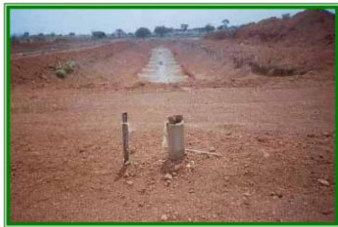
Figura 03 - Vala do Aterro Sanitário de Porto Nacional
