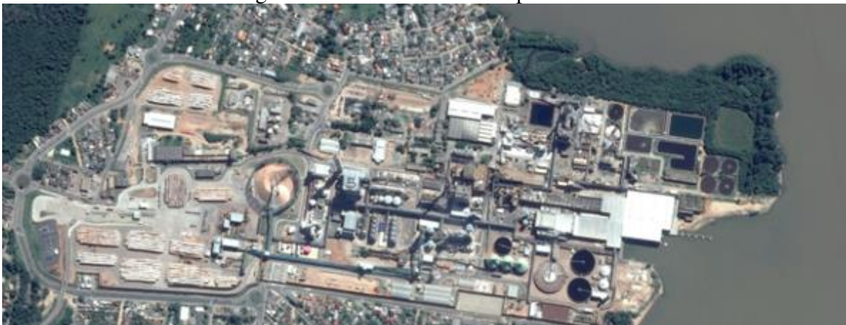
Figura 1 – Vista aérea de uma planta de celulose
