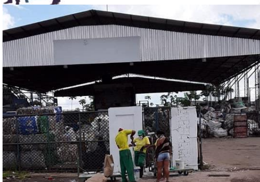
Figura 1: Fachada do galpão da ARAL
